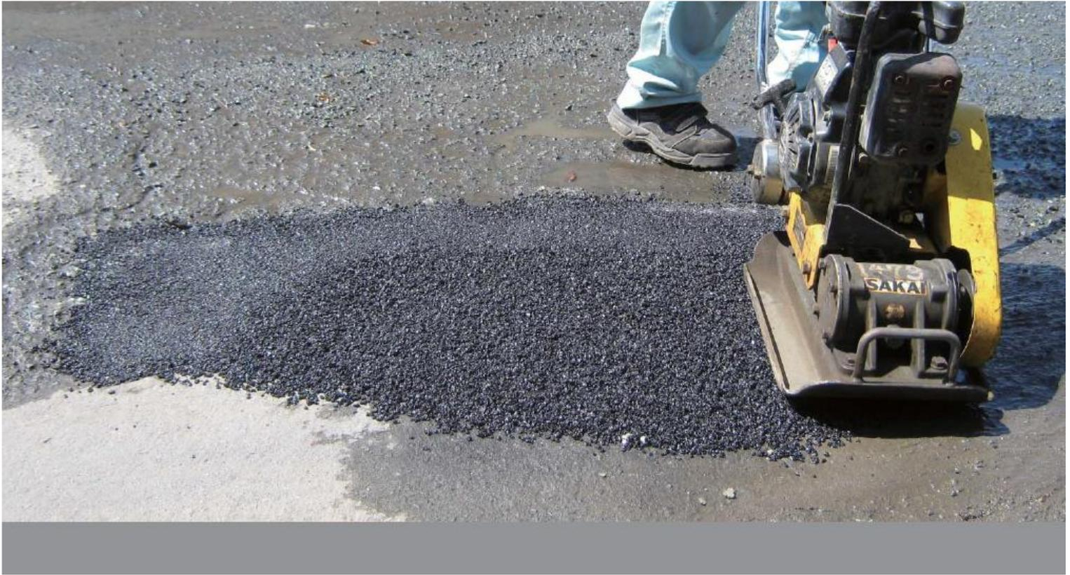
**概要** コールドパーミックスHは、高耐久型常温補修用アスファルト混合物です。
